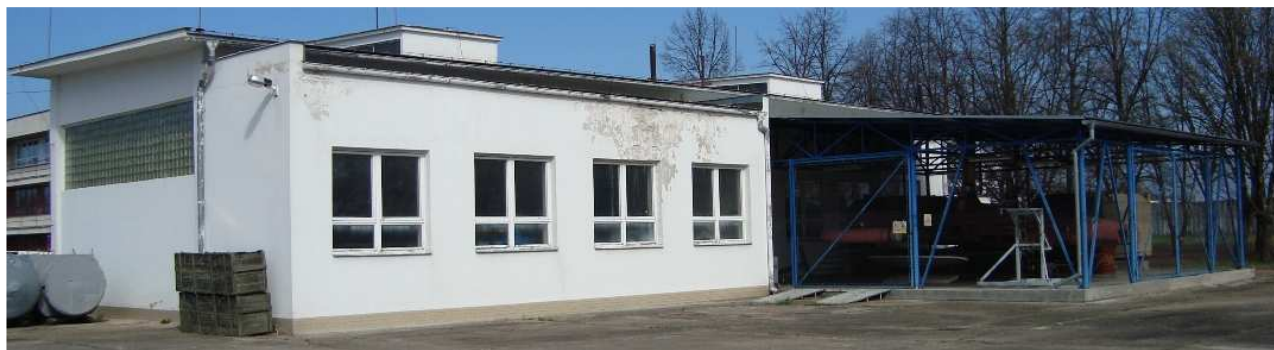
Foto č. 8 - Objekt č. 22 - Zkušebna, celkový pohled.
