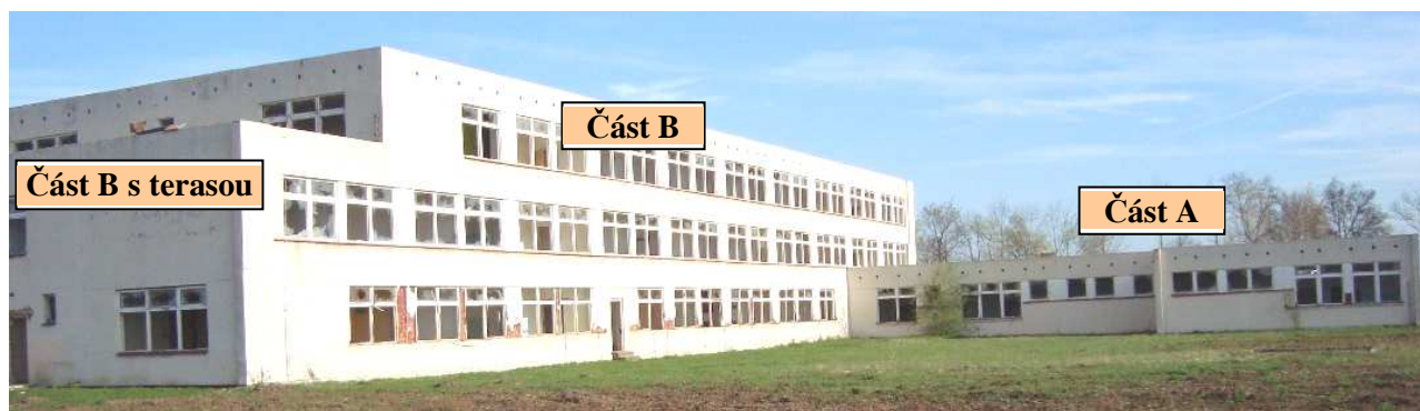
Foto č. 1 - Pohled na obě části objektu č. 116 - ubytovna.
