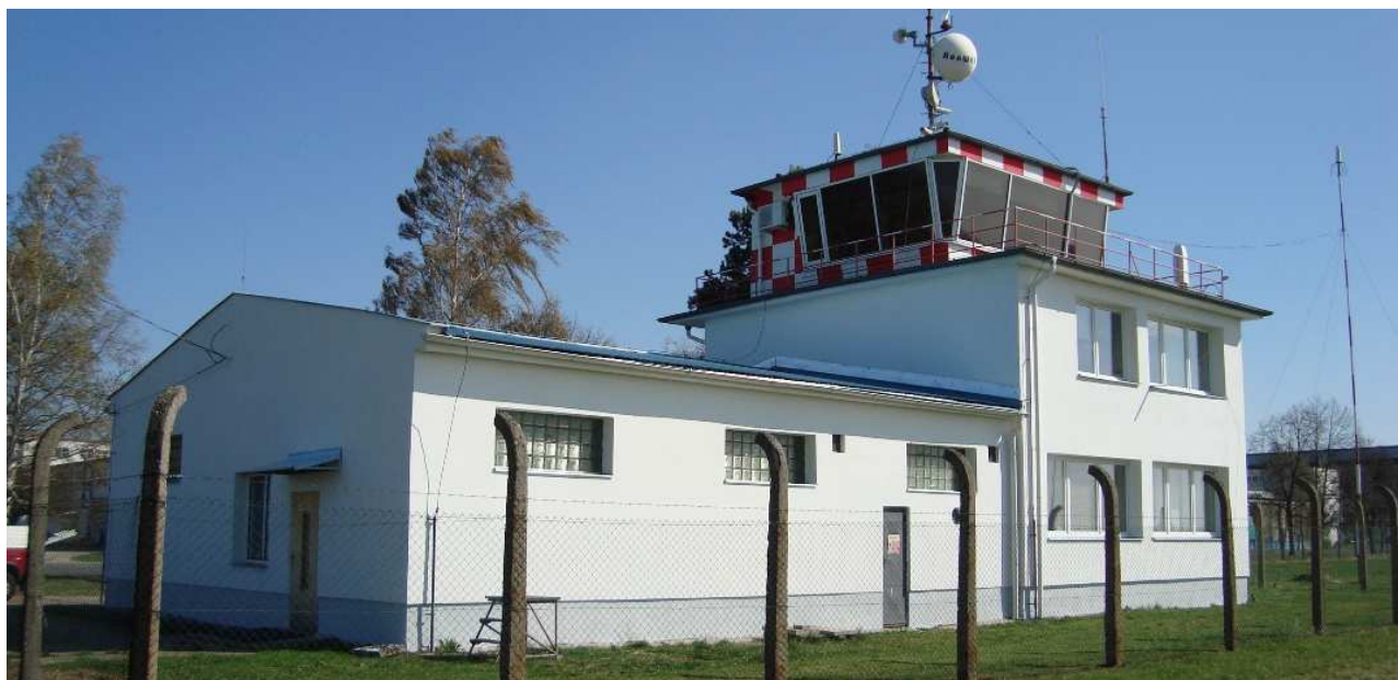
Foto č. 5 - Objekt č. 79 - věž letové kontroly. Celkový pohled na objekt od přistávací dráhy letiště.
