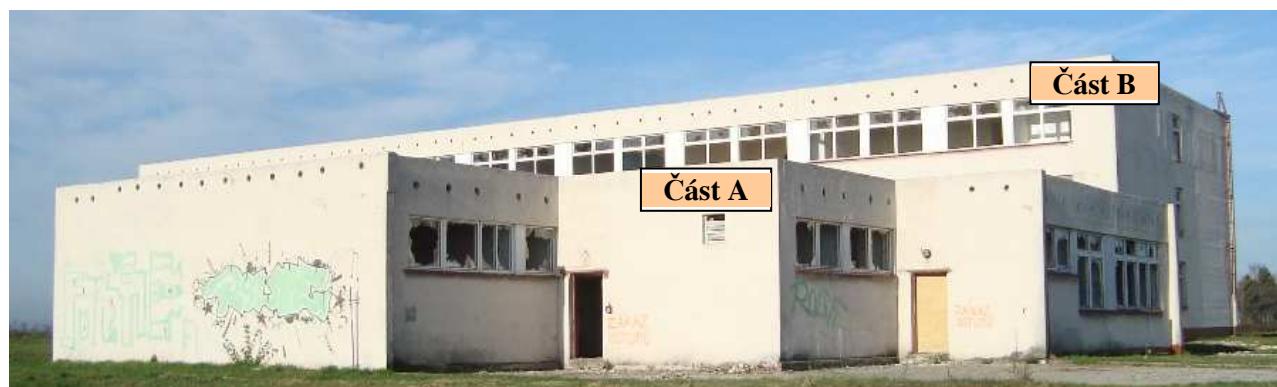
Foto č. 2 - Pohled na obě části objektu č. 116 - ubytovna.
