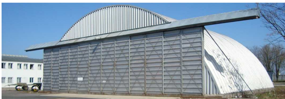
Foto č. 9 - Objekt č. 132 - Hangár (dříve L410). Celkový pohled.
