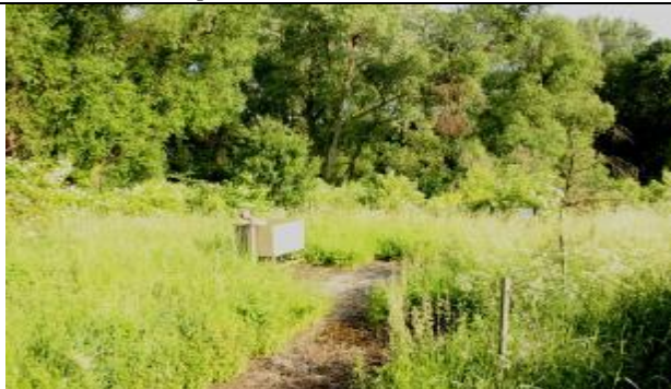
Poloha předčisticího zařízení (odlučovač s koksovým filtrem) v horní části povodí Hořtického potoka
