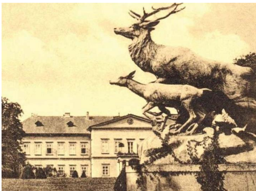
Obrázek 5 Východní průčelí zámku se sousoším jelena na ose zámku – předválečné období (sousoší jelena byla rozdrčeno a měl jím být zasypán severní rybník v parku za protektorátu) © foto – soukromá sbírka Martina Hakaufa
