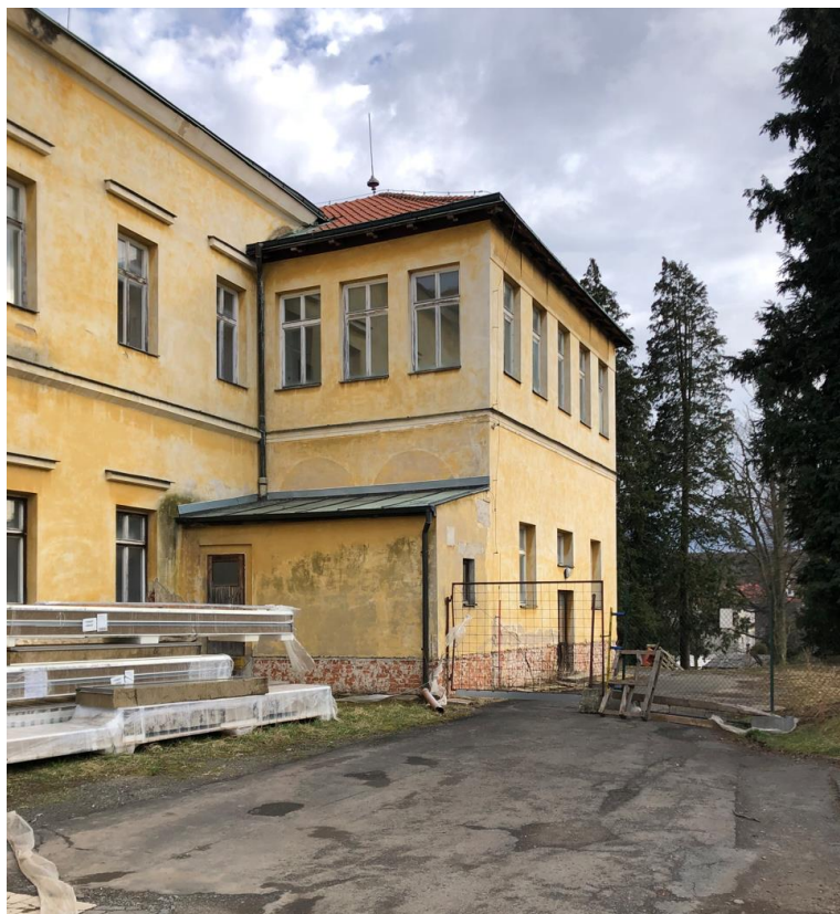
Obrázek 13 Zbytek přestavovaného západního křídla rok 2023 © foto – AbtSmolen 2023
